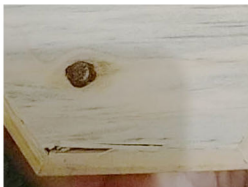
Mata kayu dan tidak rapi
